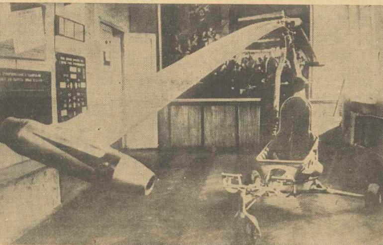
El helicóptero uniplaza, "VHR-1", de 210 kilos de peso, propulsado por un reactor situado en uno de los extremos de su motor, y que ha sido construido por los estudiantes del Instituto de Aviación de Kuryshhev. Puede ser usado por geólogos, pescadores, obreros de comunicaciones y alpinistas (FOTOFIEL).
