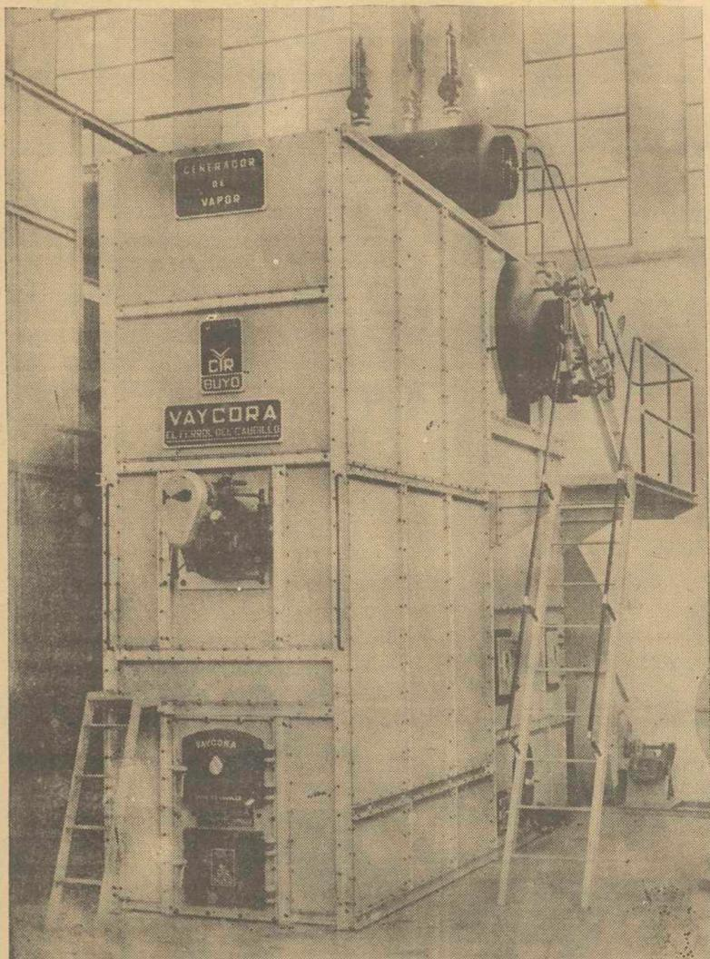
Generador de vapor de 2.000 Kg/h a 15 Kg/cm<sup>2</sup> Combustión mixta. Desperdicios de madera y fuel-oil. Instalada en VIUDA DE AVELINO SAN LUIS. Santiago de Compostela.
