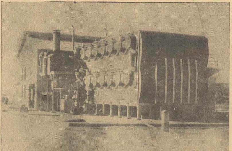
Esta instalación evaporadora británica funciona, en parte, con el calor proporcionado por los gases de escape de un motor diesel de central eléctrica. Está situada en Bonafre (Antillas Holandesas). Algunas de estas centrales evaporadoras producen hasta 50 millones de litros diarios de agua dulce procedente del agua salada.
