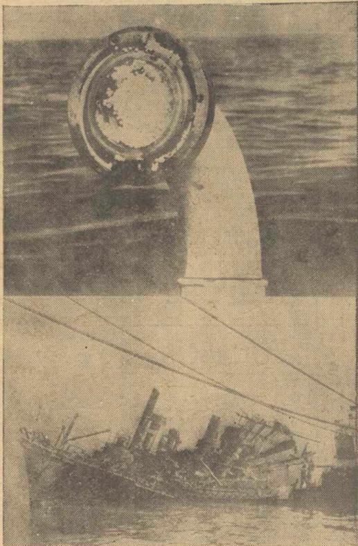
(Arriba) Las bolitas de "Styropor", del tamaño de una pita, fueron introducidas en el barco por presión mediante mangueras de incendios. Tras mes y medio quedó terminada la proeza alemán-danesa y el buque estuvo levantado. --- (Abajo) Los esfuerzos fueron coronados de éxito: la nave "Al Kuwait" está a flote. Falta solamente enderezarla por completo para poder remolcarla a los astilleros a fin de repararla.
