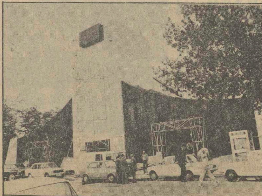
Fachada del recinto de la Feria Internacional de la Construcción y Obras Públicas FICOP 75, que se celebrará del 1 al 12 de octubre en la Feria del Campo de Madrid. — (Foto CIFRA GRAFICA)
