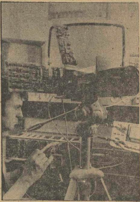
La foto muestra la nueva cámara de TV en color con un solo tubo. En vez de necesitar tres tubos para el rojo, el verde y el azul, va equipada con uno sólo, lo que permite reducir considerablemente el tamaño de la cámara, ideada por Siemens, ideal para las instalaciones móviles de color para reportajes, es un filtro de color que descompone ópticamente los tres fundamentales de la imagen procedente del objetivo. — (FOTOFIEL)
