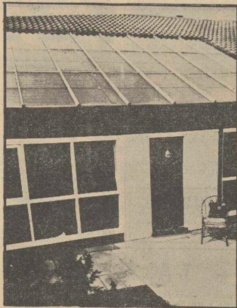
La casa solar de Milton Keynes. Una parte de las tejas han sido reemplazadas por placas de vidrio que protegen al colector de energía solar. - (Foto EFE-FIEL)
