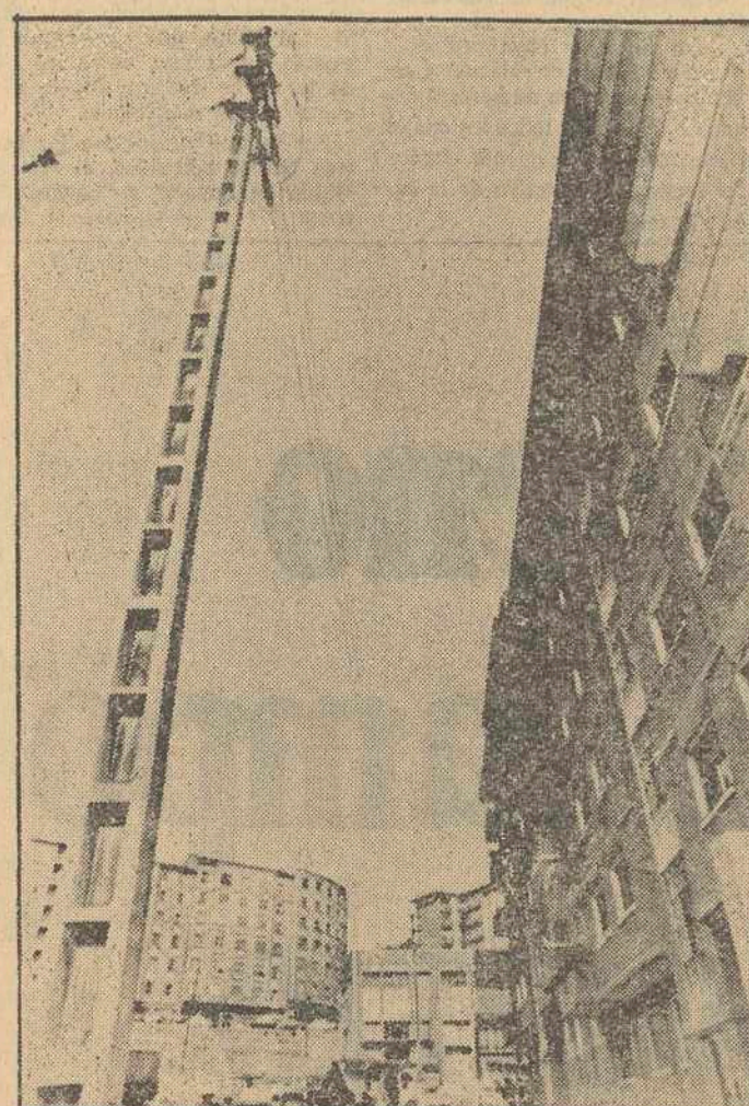
Un guardia civil resultó muerto, la mañana del pasado domingo, al intentar retirar una bandera separatista vasca colocada en el tendido de alta tensión que aparece en la fotografía. El guardia civil murió electrocutado. (Foto CIFRA GRAFICA)
