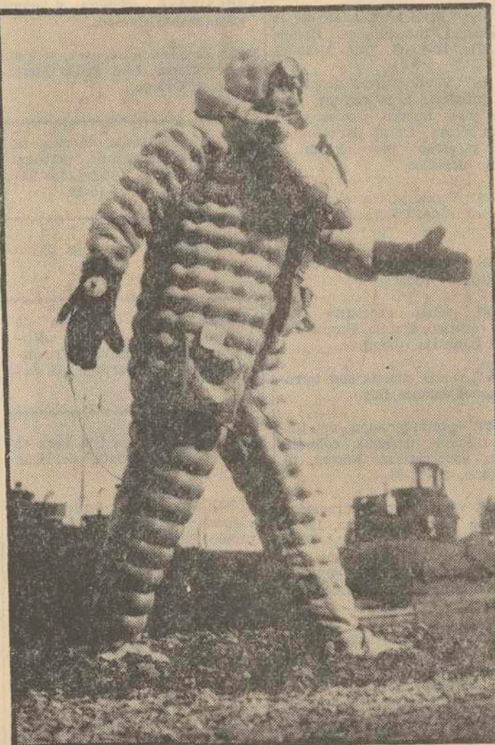
El hombre ha intentado siempre defender su cuerpo contra el agua, el frío y el fuego. En esta fotografía aparece un traje de superprotección usado por la Marina británica para el salvamento de los submarinistas. Se hincha automáticamente, mediante unas botellas de dióxido de carbono. — (Foto Efe - Fiel)
