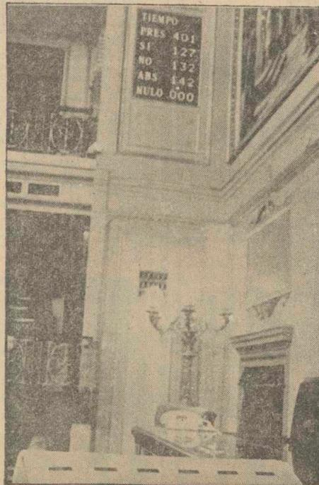
En el Palacio de las Cortes está finalizando la instalación de tableros, pulsadores y paneles electrónicos para el recuento de votos. La instalación se utilizará por primera vez en el próximo pleno del día 29. En la foto aparece un recuento imaginario llevado a cabo durante una de las comprobaciones y enumera, de arriba abajo, los procuradores presentes, los votos afirmativos, los negativos, las abstenciones y los votos nulos, que en este caso no sería ninguno. — (Foto CIFRA GRAFICA)
