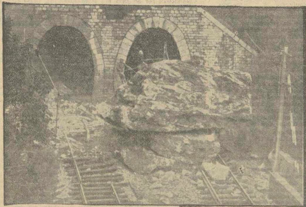
Treinta mil toneladas de rocas han caído sobre la vía férrea de «Basso Cornicho», en las inmediaciones de Niza, en plena Costa Azul, destrozando varios tramos del tendido y causando diversos daños. — (Foto CIFRA GRAFICA-UPI)
