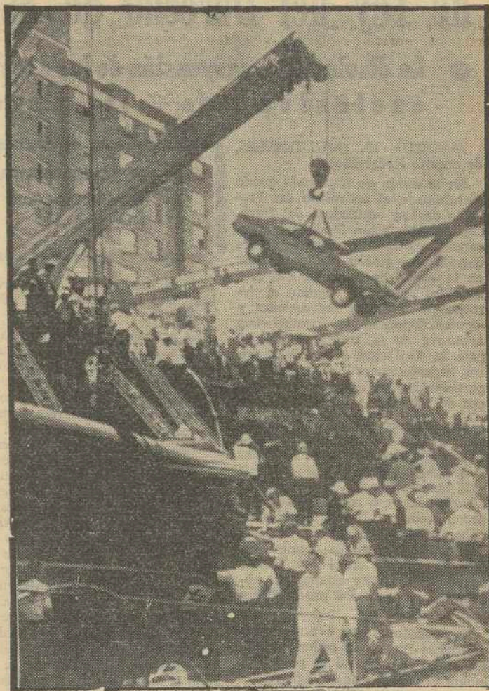
Esta es la trágica estampa del tren de cercanías sobre el que se desplomaron los pretilos de un puente, al haber chocado contra uno de sus pilares en las inmediaciones de la ciudad australiana de Sidney. Un automóvil es levantado de entre los escombros, mientras cuatro grúas intentan separar los restos de los diferentes vagones convertidos en un montón de materiales destruidos. Más de setenta cadáveres han sido recuperados de entre los restos del tren, y casi un centenar de heridos han tenido que ser hospitalizados. Los cirujanos han tenido que llevar a cabo amputaciones en el mismo escenario de la tragedia. — (Foto CIFRA GRAFICA)
