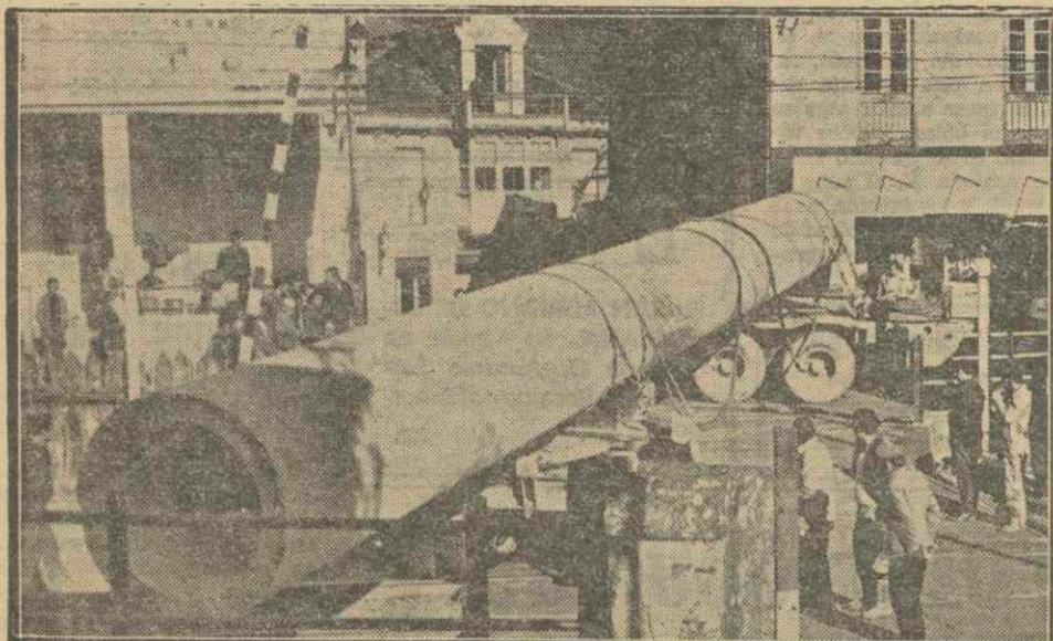
A buen ritmo se están construyendo los puentes sobre el río Sil de la vía de penetración a Galicia. En el grabado les ofrecemos una información gráfica del paso de un pedestal de dichos puentes, de 21 metros de largo, prefabricado, que con gran dificultad y pericia del encargado de dicho transporte, logró cruzar el paso a nivel de San Clodio ante la curiosidad de todos los vecinos. — (Foto ANTONIO VIDAL)
