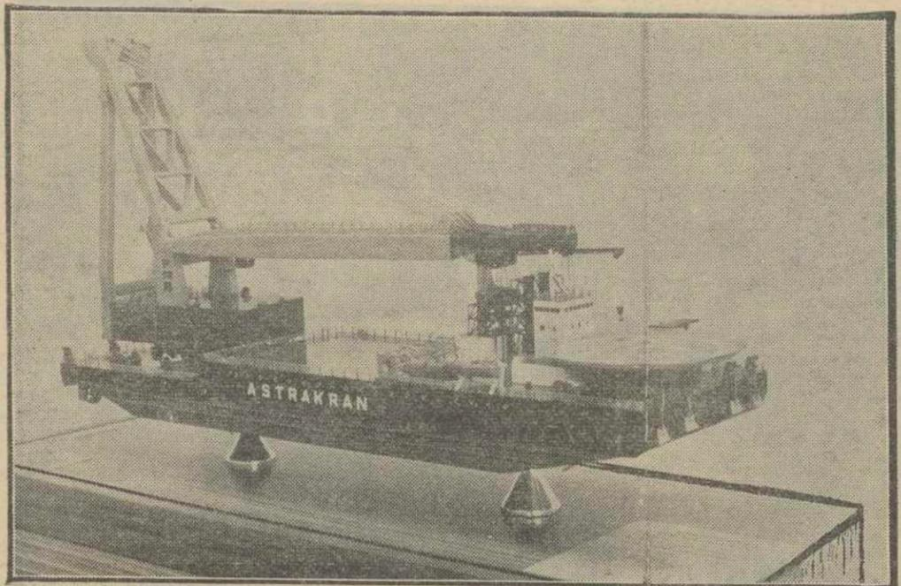
Esta grúa flotante se está construyendo en los astilleros alemanes por encargo de la Unión Soviética. La grúa, con sus ciento veintisiete metros de eslora (el largo) y sus treinta y cuatro y media de manga (el ancho), es una de las mayores del mundo y puede levantar dos mil quinientas toneladas. Entrará en servicio en el próximo año, y tendrá una tripulación de ciento veinte hombres. — (FOTOFIEL)
