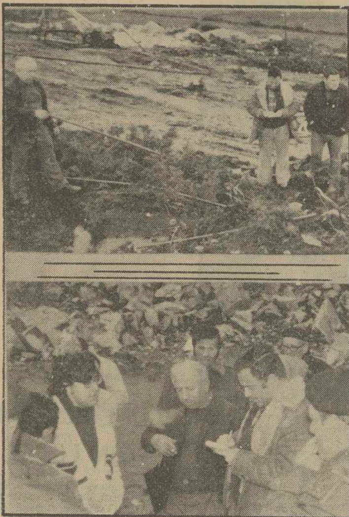
Arriba, el señor Bermúdez, uno de los vecinos de Lieiro, muestra a nuestro compañero las tuberías provisionales que fueron colocadas para suplir las que fueron destruidas por la explotación de la cantera. Abajo, al pie de la cantera, un grupo de vecinos responden a las preguntas de nuestro enviado especial. — (Fotos SERGIO)
