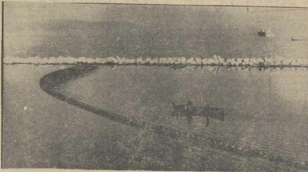
Esta ingeniosa cadena de latas, instalada en el canal de La Mede-Martigues (en la desembocadura del río Ródano), forma una eficiente barrera para contener el petróleo que inevitablemente se pierde al ser descargado en el puerto de La Mede. — (FOTOFIEL)
