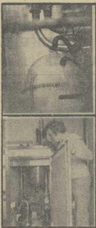
El agua del estrato natural, que atraviesa una segunda bomba de calor (foto de abajo), permite a Ebeling calentar su casa
