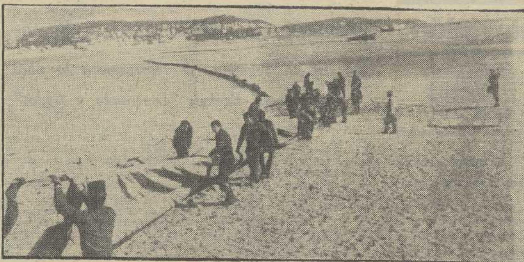
En la Costa Azul francesa acaban de realizarse unas importantes maniobras de protección de las playas contra mareas negras y otras contaminaciones mediante barreras hinchables. Francia dispone actualmente de unos 23.000 metros de barreras hinchables iguales a los que se utilizaron en los ejercicios de la Playa de Carras recogidos en la foto. — (FOTOFIEL)
