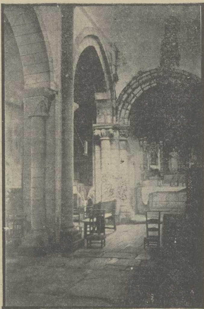
Abside; capilla del lado de la Epístola
