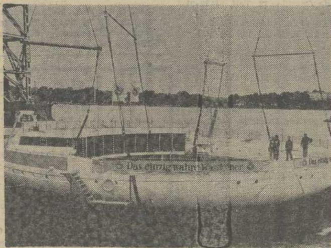
Este "atolón artificial" ha sido anclado en el Mar Báltico, a algo más de 200 metros de la costa de Travemünde (Alemania). Circular y con un diámetro de 27 metros, se compone de cuatro cubiertas y dispone de restaurante-bar, piscina interior, vestuarios y embarcaderos. La "isla", toda de plástico, ha sido diseñada por un ingeniero alemán de Munich. (FOTOFIEL)
