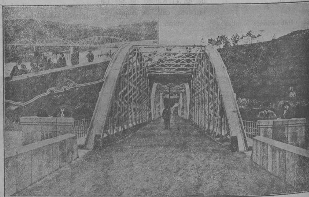
CORUÑA. — El conocido Puente del Barquero
