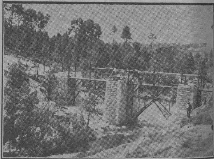
CARBALLINO.—Obras del ferrocarril Zamora-Coruña. Viaducto sobre el río Arenteiro.
