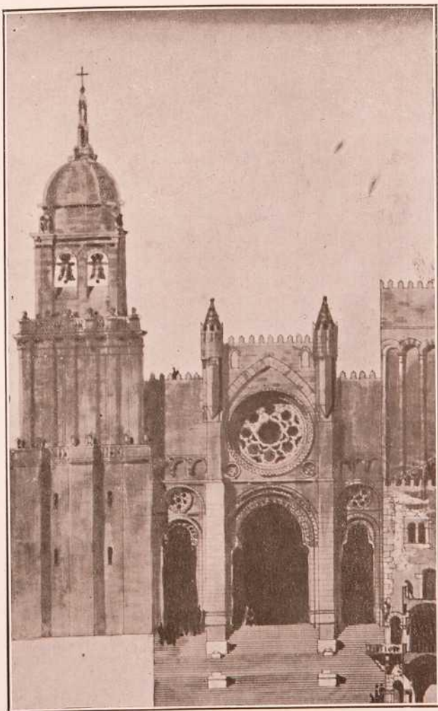
Detalles de la fachada principal de la Catedral despu3s de su restauraci3n
