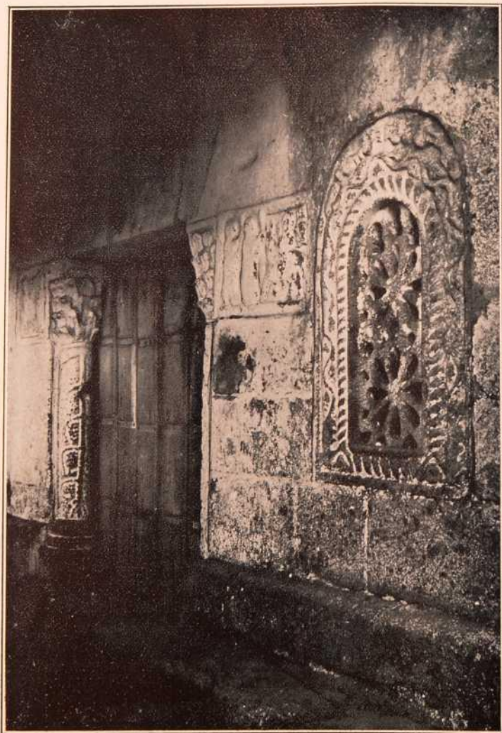
Vista de conjunto de la fachada de la Capilla de Francelos
