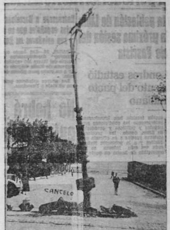
Estado en que quedó esta columna después de cables del tranvía, en la calle de Sánchez Bregua, a consecuencia del choque de un autobús.
