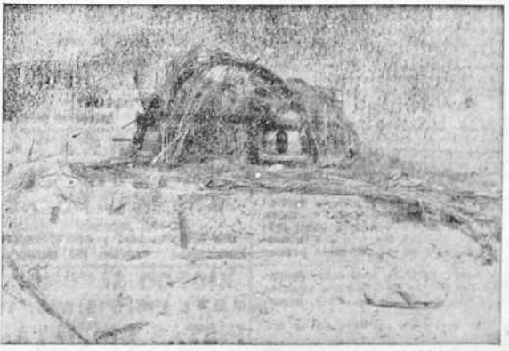
Torreta blindada de una de las fortificaciones de primera línea del frente Oriental de la Libia
