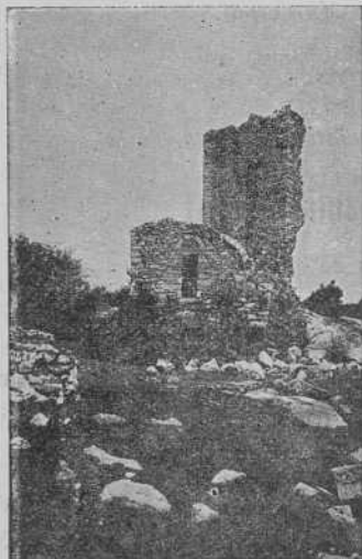
Torres del Oeste
