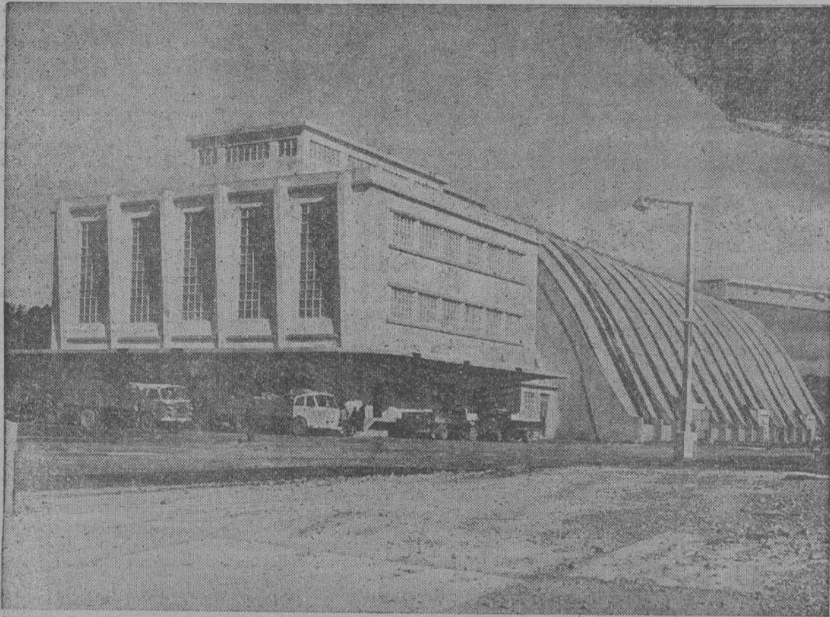
Almacén del producto terminado, ensacado y carga del abono en camiones. Este almacén tiene una capacidad para 20.000 toneladas
