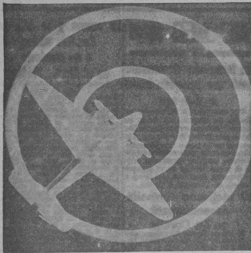
Una nueva lámpara visora, ideada por los ingenieros luminotécnicos americanos, permite a los ametralladores apuntar sus armas cara a la luz del sol. Los dos círculos blancos del visor destacan perfectamente a pesar del resplandor, al apuntar la ametralladora contra un modelo en miniatura colocado sobre el fondo de un sol brillante.
