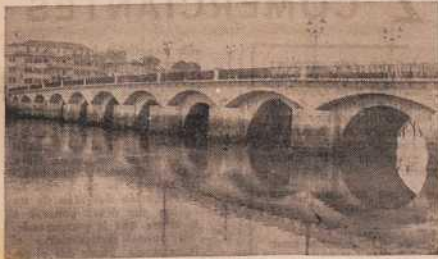
El puente del Burgo.
