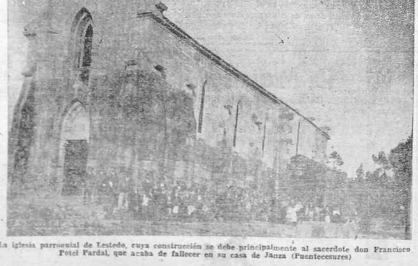
La iglesia parroquial de Laredo, cuya construcción se debe principalmente al sacerdote don Francisco Pótel Fardal, que acaba de fallecer en su casa de Jansa (Puntescueras)
