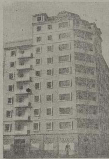
Pontevedra.—Bella perspectiva que ofrece el grupo de viviendas de la calle de Sagasta, en esta capital, cuya entrega será efectuada en fecha próxima —(Foto Tíve).
