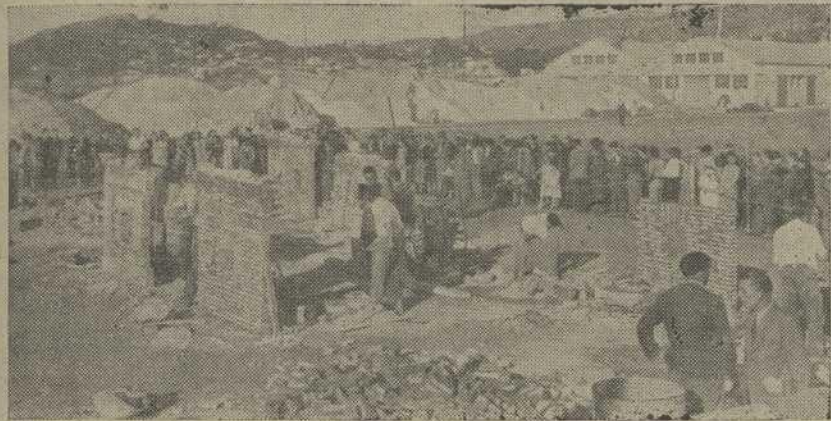
Los concursantes de albañilería en plena actividad
