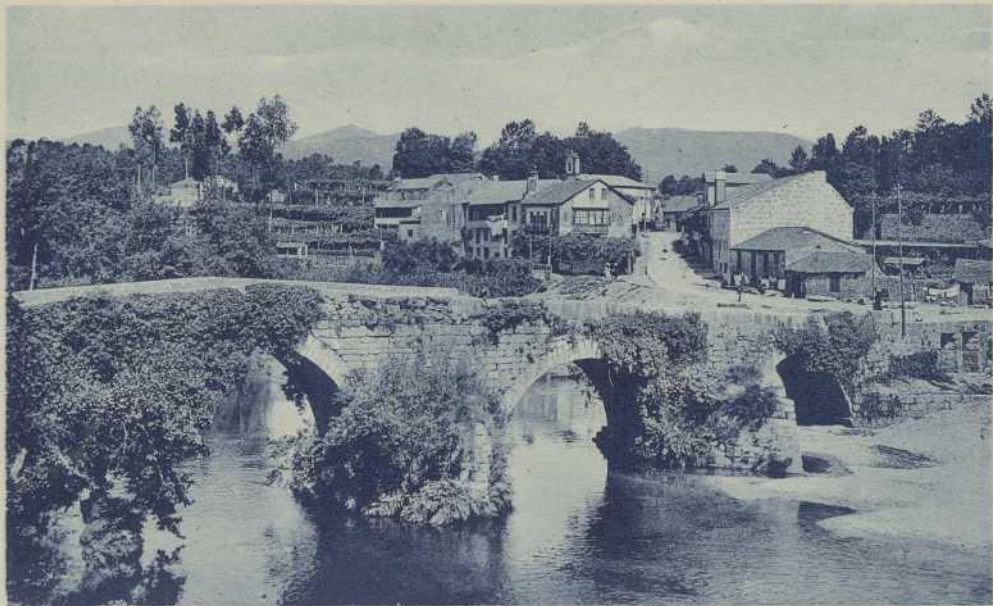
7. PUENTEAREAS — Puente Viejo
