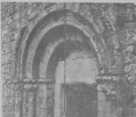
SANTA MARIA DE VILLARAGUNTE Pormenor de la puerta principal
