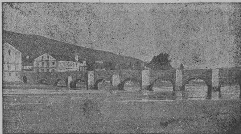
PUENTE CESURES-Vista del Puente.
