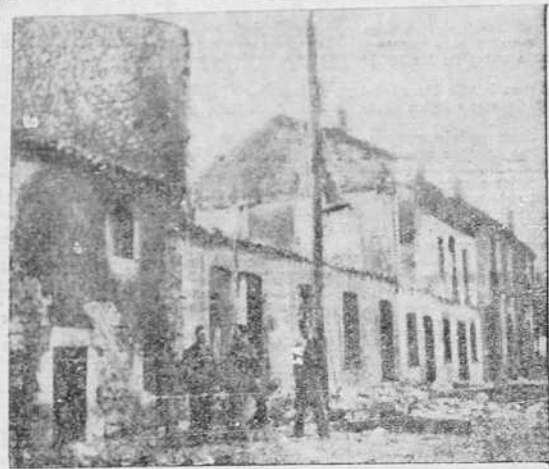
Pol de Gondán. Otro aspecto de la villa destruida por las hordas rojas. La campana que aparece colgada de un poste de la línea eléctrica servía para avisar el paso de los aviones nacionales.
