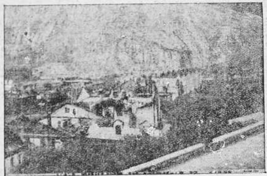
También la villa de Santa Lucía fue objeto de la ira marxista. En primer término de la fotografía aparece el cuartel de la Guardia Civil totalmente destruido.
