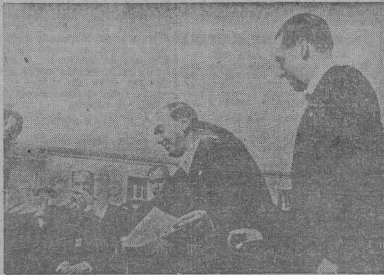
SANTA CRUZ DE TENERIFE.—El subsecretario de la Presidencia, Sr. Carrero Blanco, hace entrega a los beneficiarios de la nueva barriada "General García Escámez", construida por iniciativa del capitán general de Canarias, general García Escámez. (Foto CIFRA).
