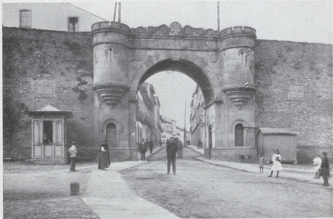
Abierta en la antigua muralla, es su construcción relativamente moderna, comunicando con la calle del mismo nombre.
