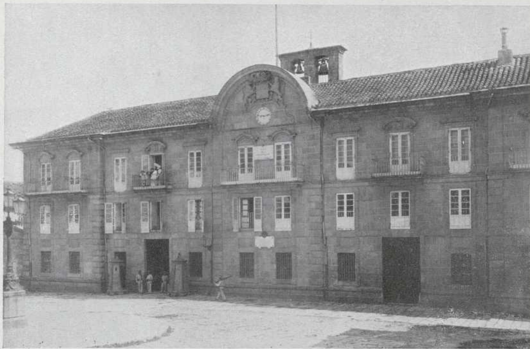
Edificio de forma cuadrangular y vastas proporciones, sin que ofrezca ningún interés artísticamente considerado.
