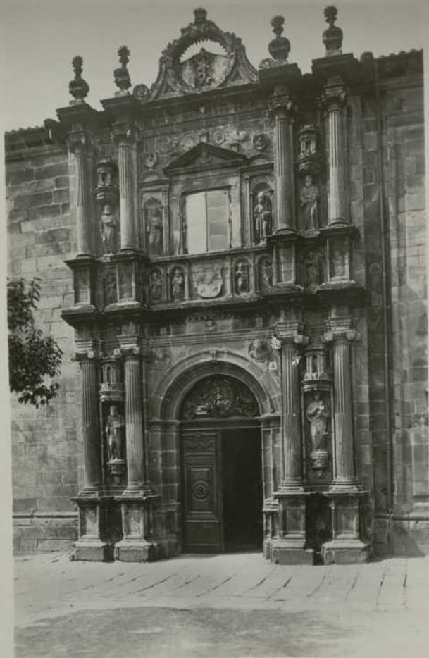
25. SANTIAGO.-Colegio de Penseca: Fachada.
