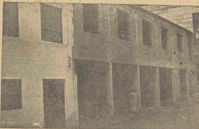
Nueva nave en construcción para ampliar el Taller de Mecánica
