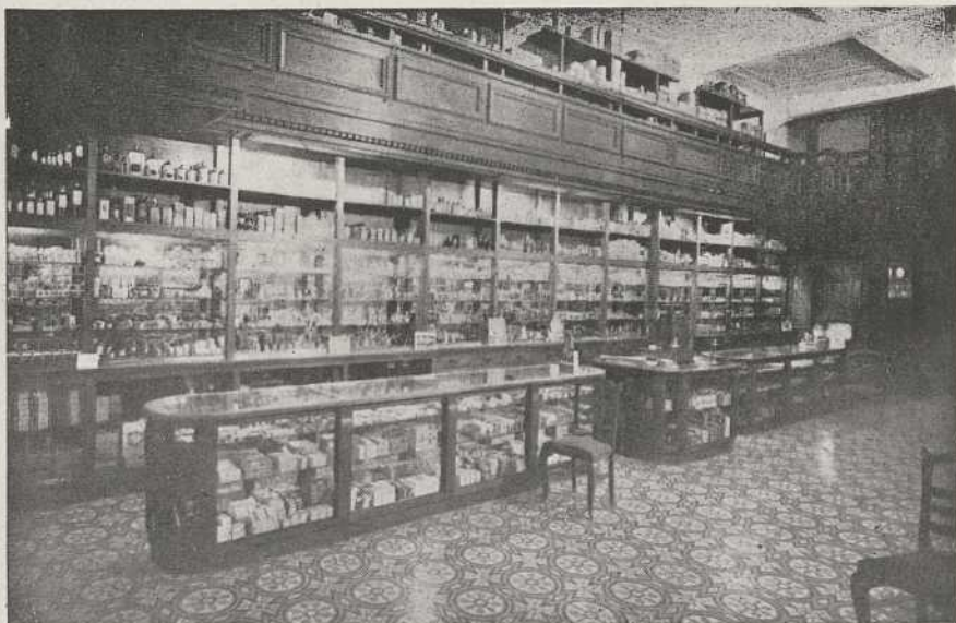
Vista interior de la DROGUERIA VILLAR
