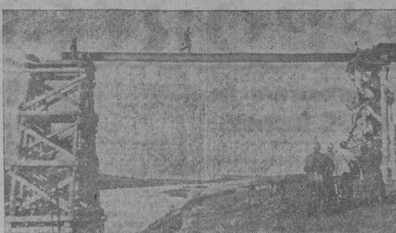
A simple vista parece ser esto un espectáculo circense al ver a este soldado que atraviesa por una de las vigas de este puente en construcción, lo que ha de realizar con gran valor, aunque no lo parezca. La labor de los zapadores alemanes requiere a veces bastantes acrobacias como ésta.
