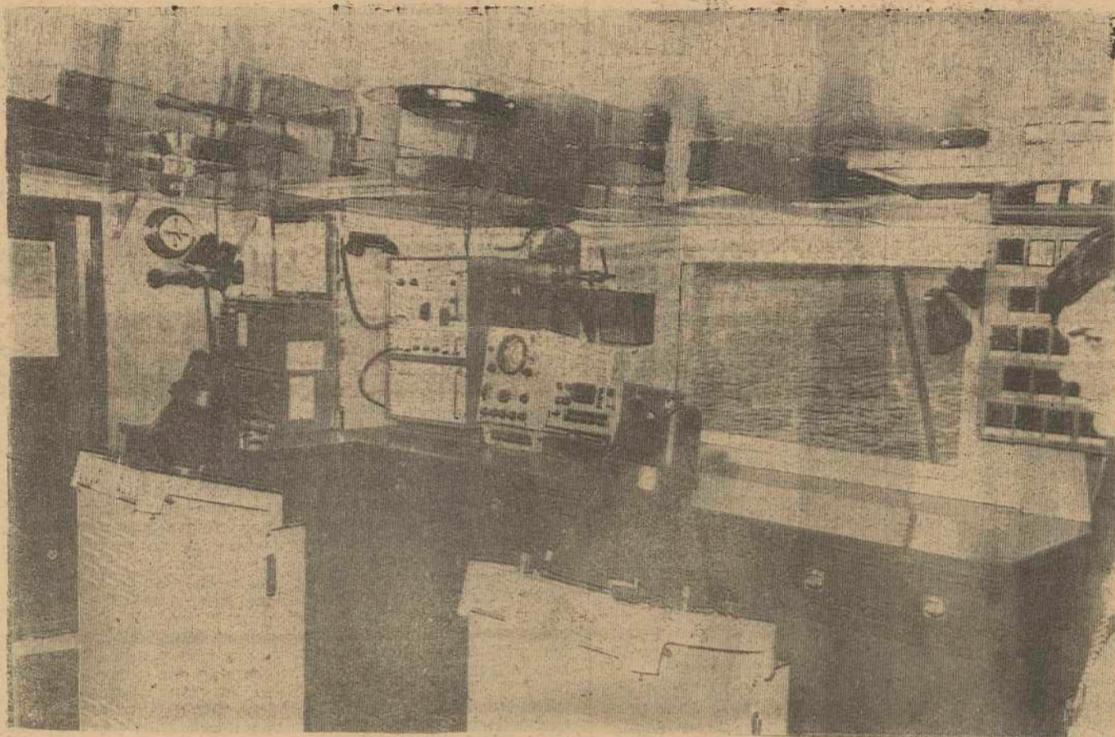
Otra panorámica interior del puente —parte posterior—, en donde van instalados aparatos precisos para una buena navegación, receptores, radioteléfono, etc.
