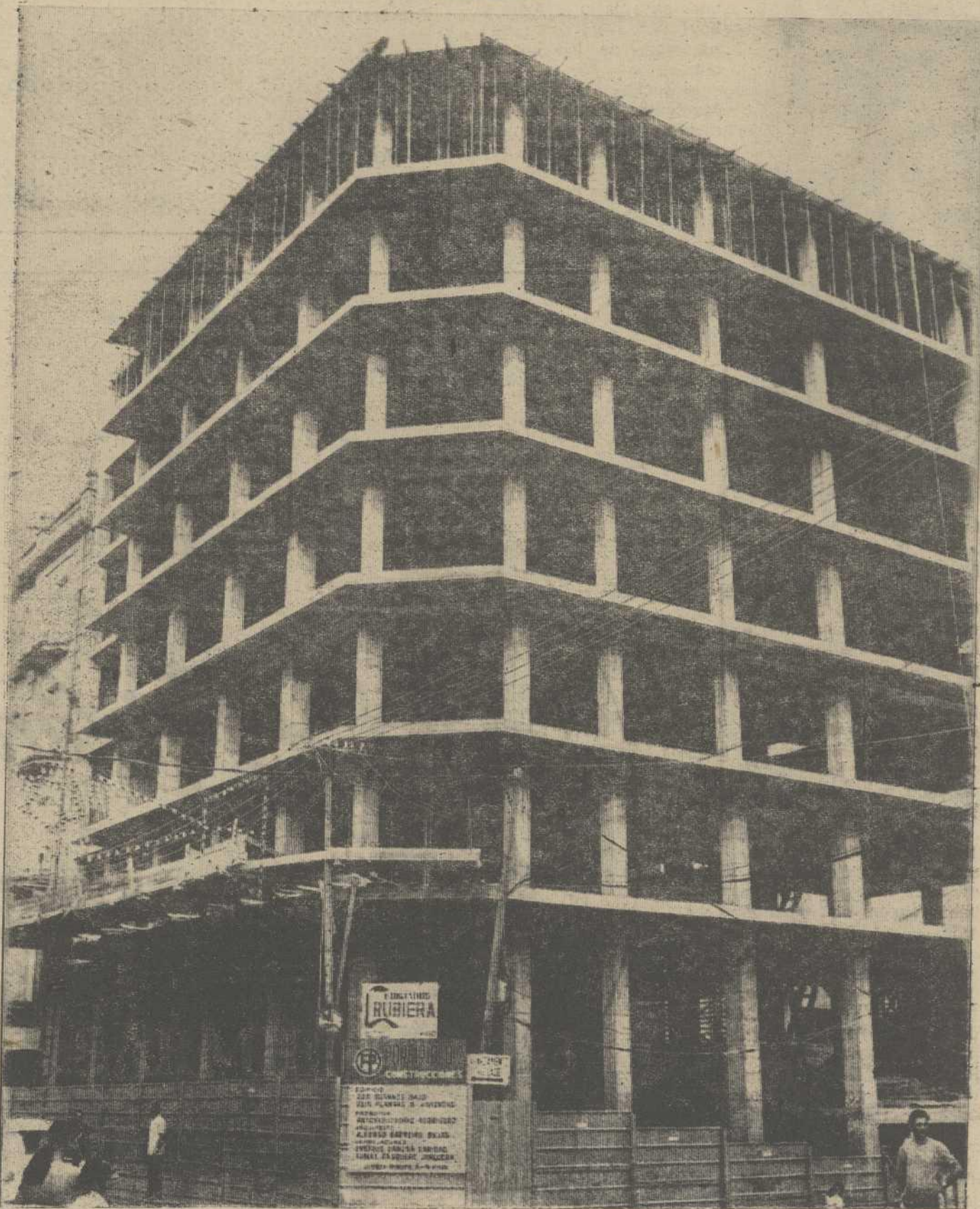
EDIFICIO EN CONSTRUCCION EN LA CALLE BENITO CORBAL, ESQUINA PLAZA BARCELOS.
