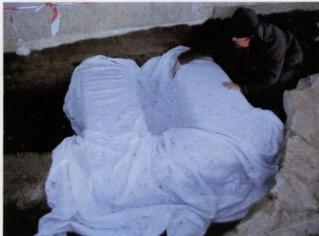
Foto 54: Sector SOA02/03. Tapado con geotextil del contrafuerte este
