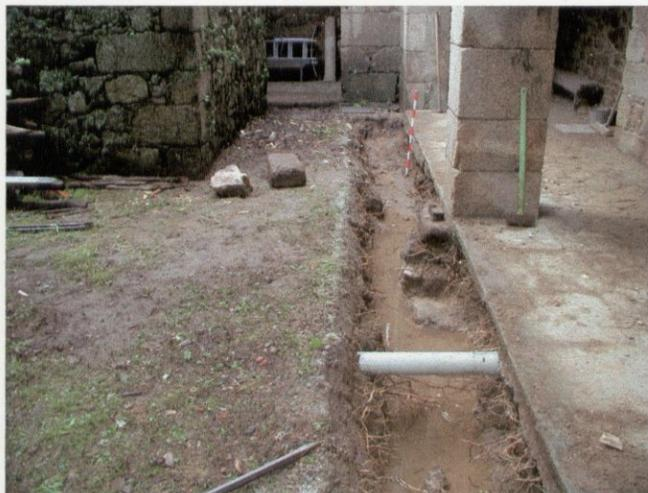
Foto 7: Sector SOA02/00. Zanja excavada para el drenaje en el flanco norte
