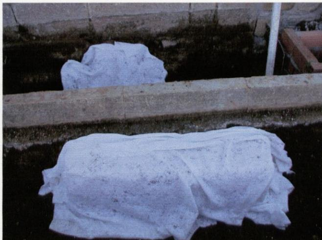
Foto 56: Sector SOA02/03. Cubricion con geotextil de los restos del contrafuerte oeste
