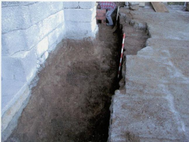
Foto 33: Sector SOA02/02. Vista final de la zanja excavada para instalar el drenaje
