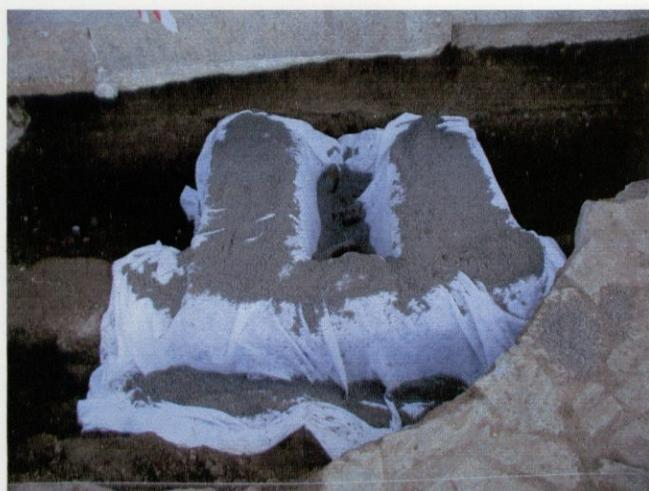
Foto 55: Sector SOA02/03. Deposito de una capa de aridos sobre el contrafuerte este
