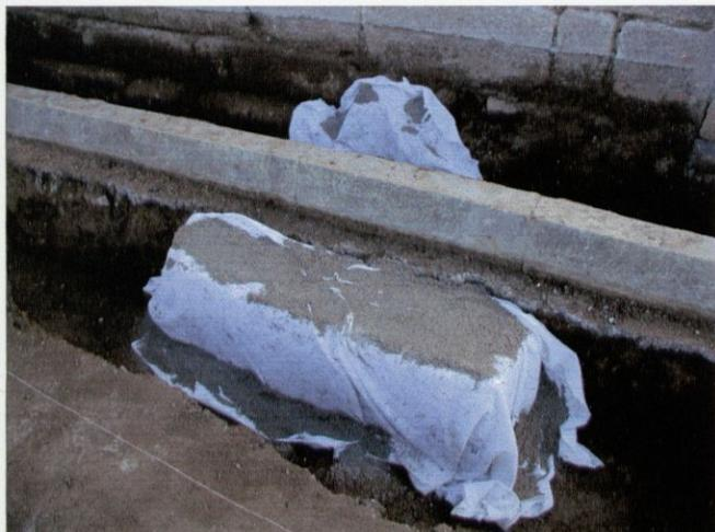
Foto 57: Sector SOA02/03. Depósito de aridos sobre los restos del contrafuerte oeste
