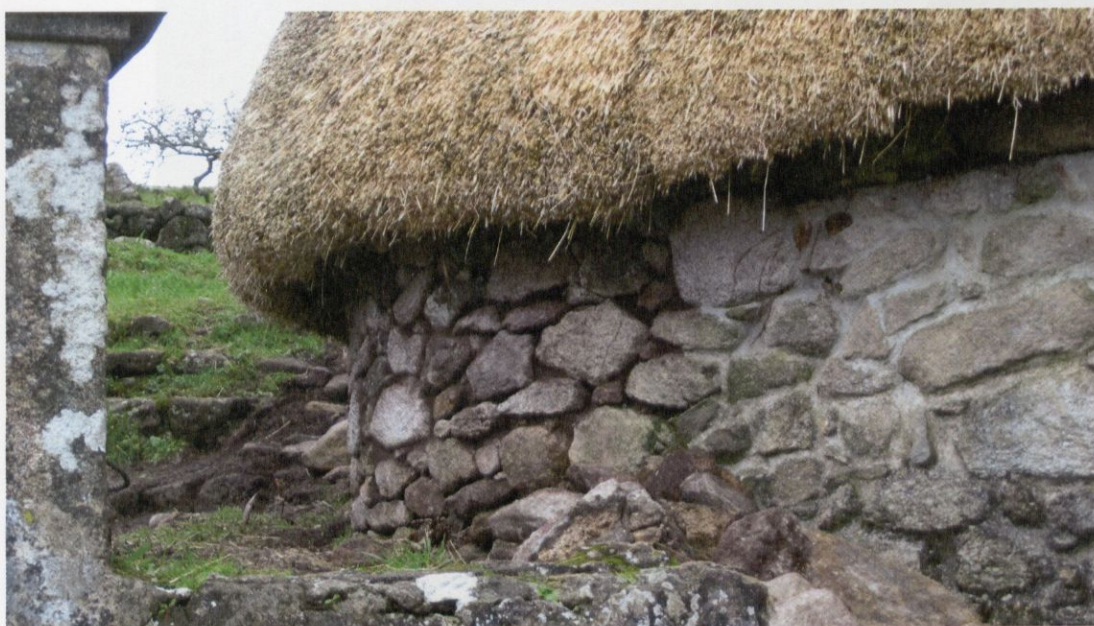
Detalles dos traballos de reparación do muro e instalación do teitado.
