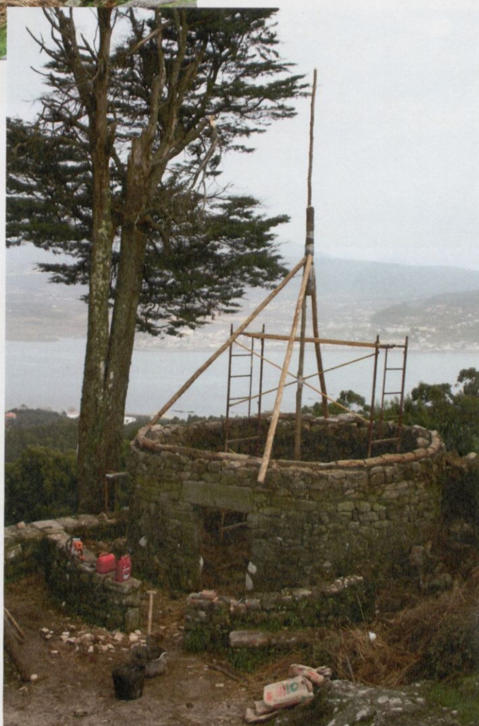
Retirada da cuberta vella moi deteriorada e instalación do novo teitado unha vez retificado o muro
