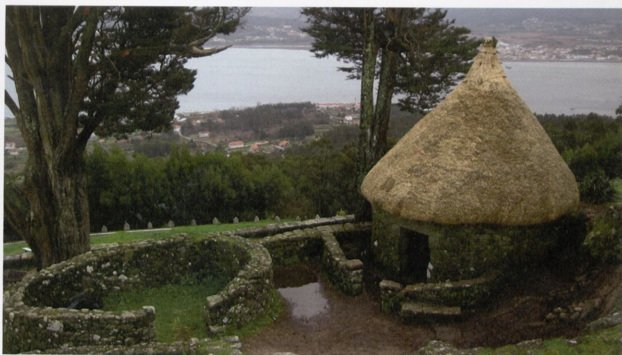
Vista xeral do sector da intervención, antes de escomenzar e unha vez rematada a actuación
