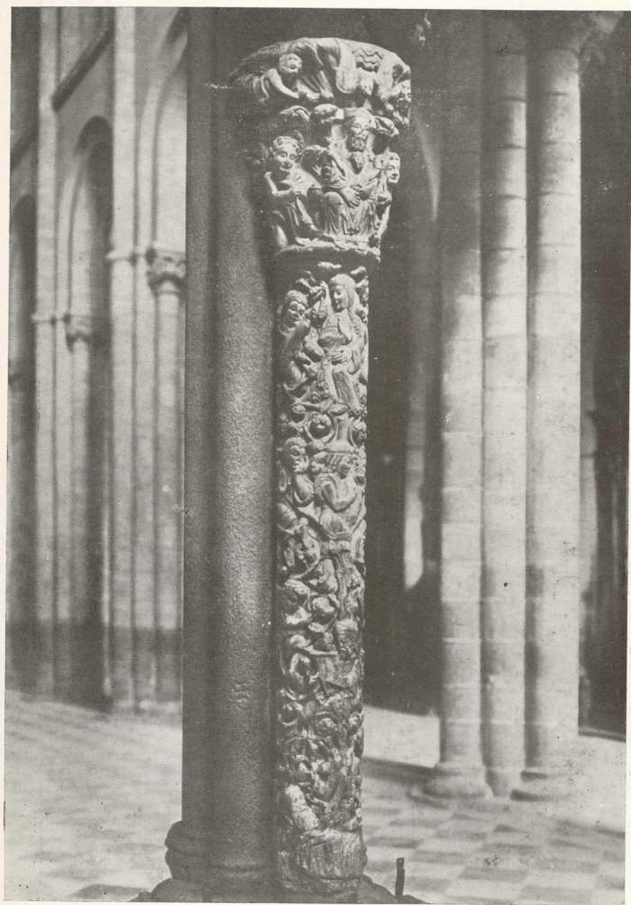
Columna historiada del parteluz
