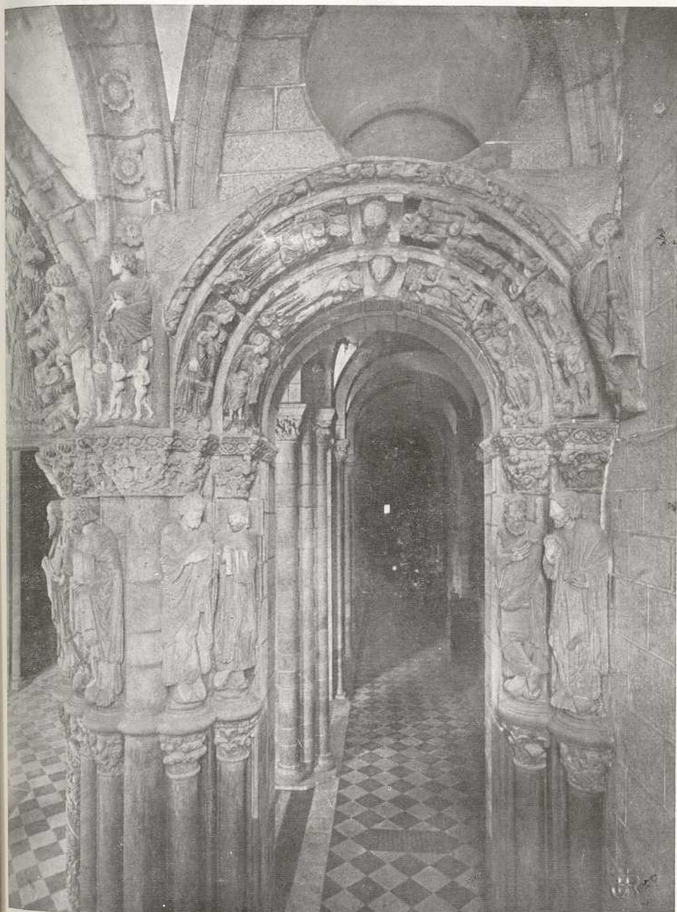
Arco lateral de la derecha
