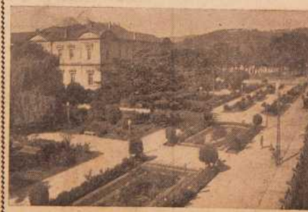
Hermoso aspecto del Jardín de Colón con el edificio de la Diputación Provincial.
