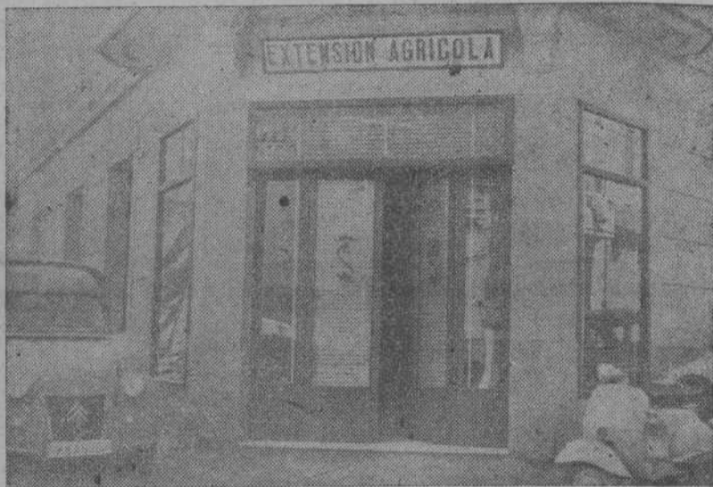
Puerta abierta a los campesinos de "Las Mariñas". Fachada de las nuevas oficinas de Extensión en Betanzos (La Coruña)
